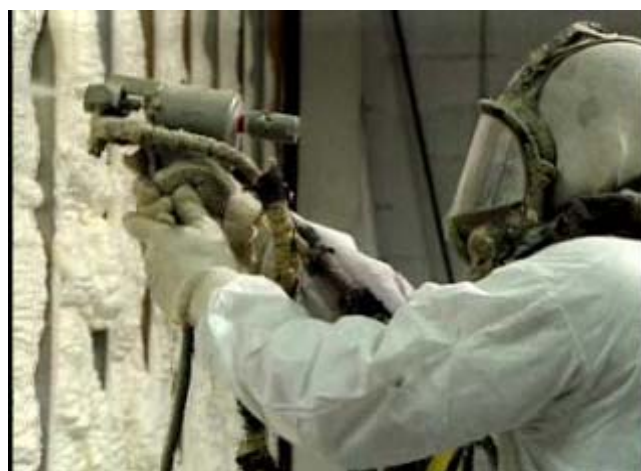
شکل ۷: اپراتور در حال پاشش فوم
