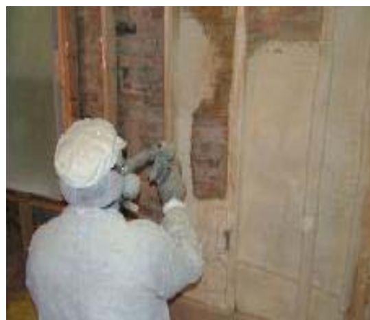
شکل ۵: فوم پلی یورتان به صورت پاششی بر روی سطوح
