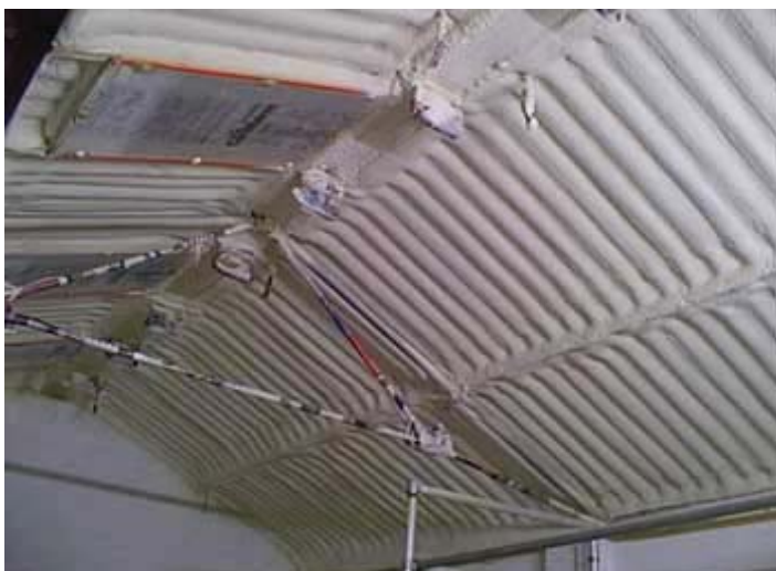
شکل ۳: نمایی از اعمال فوم پاششی پلی یورتان
