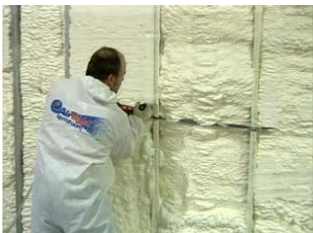
شکل ۸: اپراتور در حال برش برای صاف کردن فوم پاشش شده.
