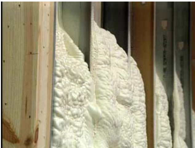
شکل ۶: فوم پلی یورتان بعد از پاشش
