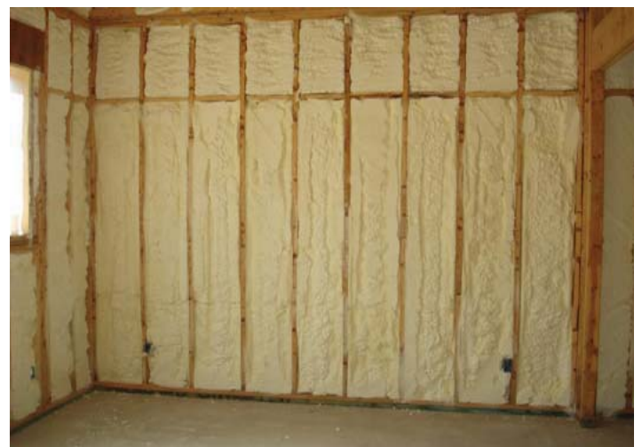
شکل ۲: نمایی از اعمال فوم پاششی پلی یورتان
