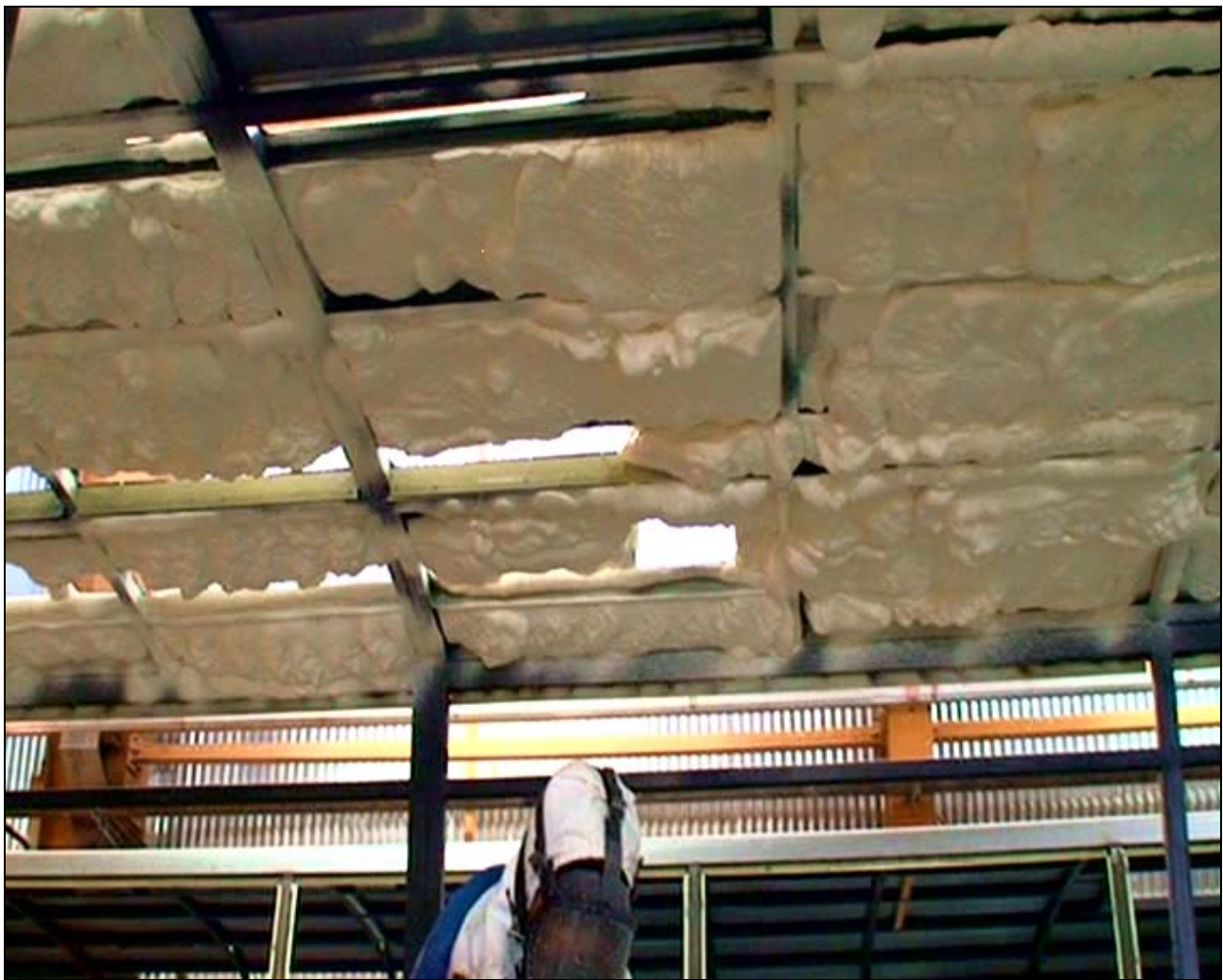
شکل ۱: نمایی از استفاده فوم پاششی پلی یورتان به عنوان عایق داخلی
